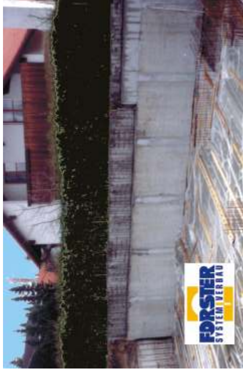
So sieht Ihre Problemlösung aus: Bodenplatte und Grenzwall sind fertiggestellt. Die Hecke blieb unberührt.
